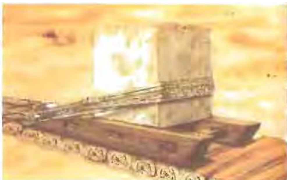
Транспортировка каменных блоков на каретках.
